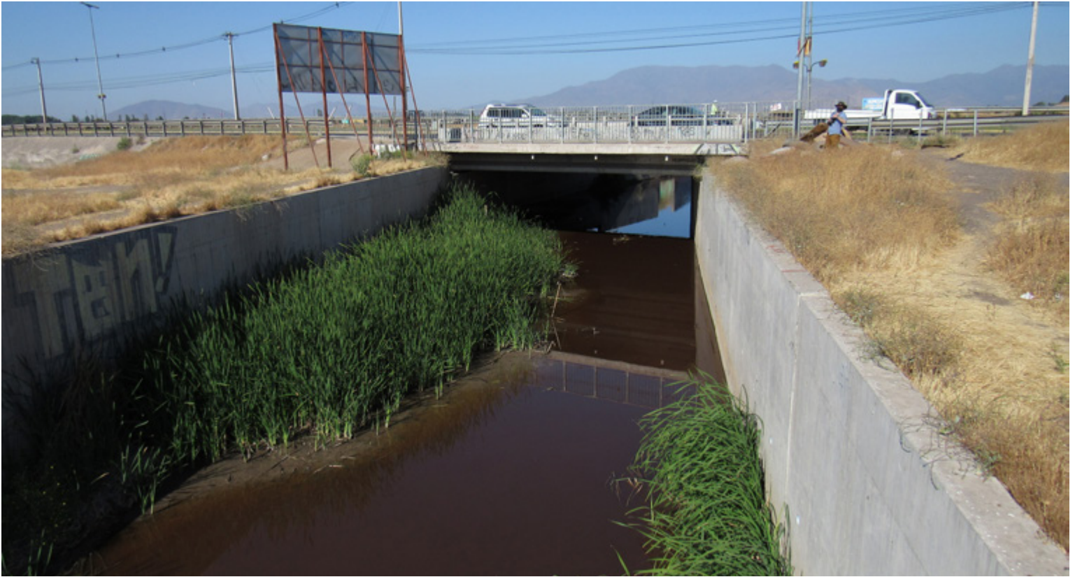
FIGURA 1 Puente sobre el estero Kūla-Kura, Quilicura, lugar de los registros de nidificación del año 2020.
